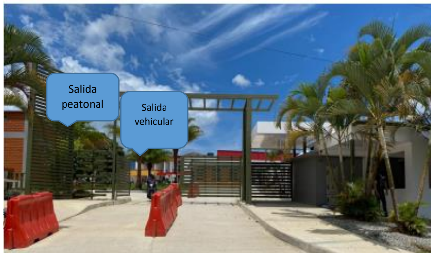
Portón principal salida de las instalaciones
