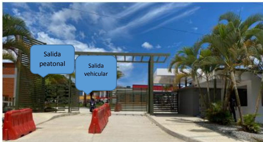
Portón principal salida de las instalaciones
